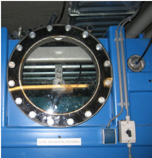
Foto 2 (links): Door het mangat is de anode te zien.
